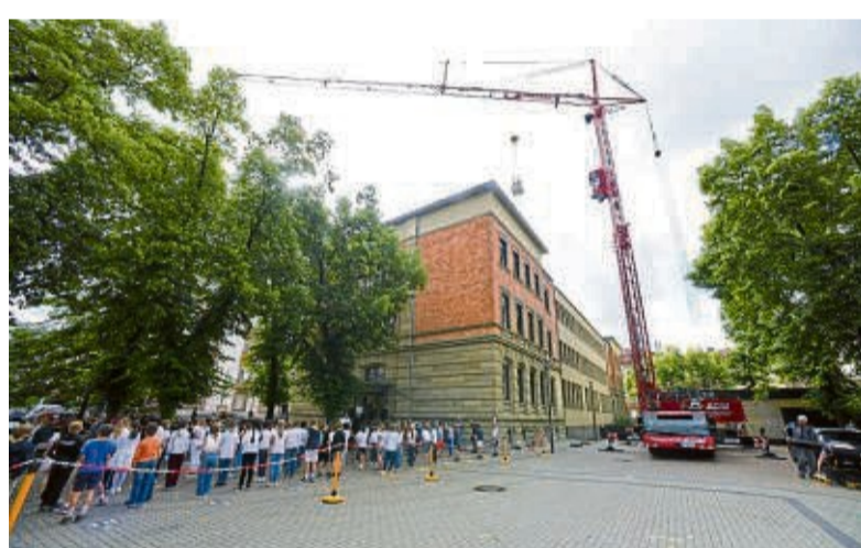
Ein Kran hievt Material für eine Photovoltaikanlage auf die Textorschule in Sachsenhausen. Die Schüler schauen zu. FOTO: RENATE HOYER
